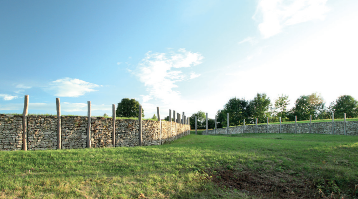
Restauriertes, keltisches Zangentor „Tor G“ bei Erkenbrechtsweiler 1
