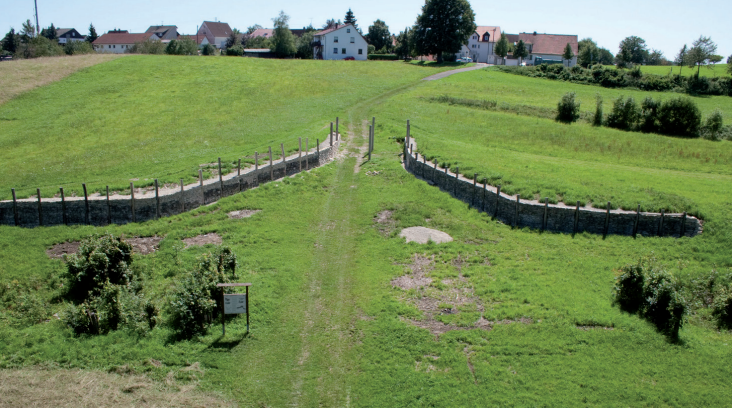
Restauriertes Zangentor im Außenbereich des Oppidums Heidengraben 1
