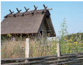
Der rekonstruierte Getreidespeicher ist mit Reet gedeckt und besteht aus Eichenpfosten mit lehmverputzten Flechtwerkwänden
